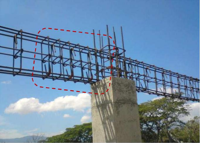
*Menor separación de aros de una viga cerca del apoyo en la columna (valores altos de fuerza cortante)*
