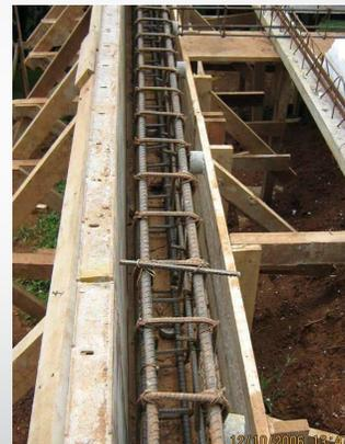
No permitir alta densidad de varillas dado que impide el paso del concreto. Esto se debe evitar desde la etapa de diseño mediante la escogencia de un ancho de viga apropiado.
