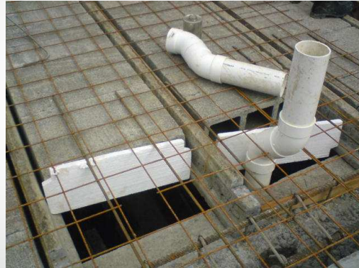
Interacción sistemas electromecánico y estructural. Paso de tubería de aguas negras a través de los bloques del entrepiso.
