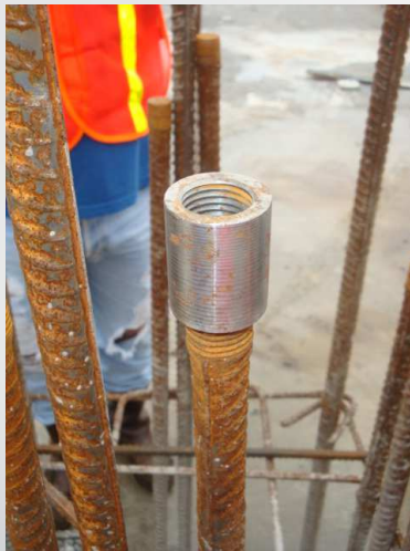
Ejemplos de empalmes mecánicos utilizados en la construcción del Estadio Nacional
