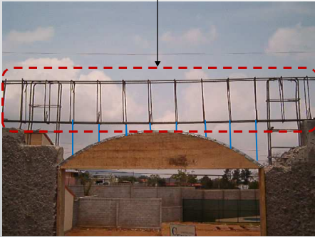
Construcción de viga cargador en forma de arco
