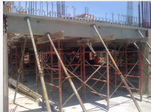
Uso de andamios de carga como sistema de apuntalamiento en vigas de entrepiso
