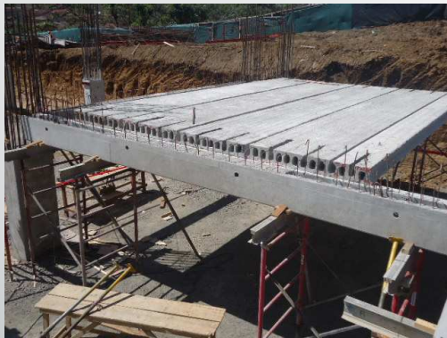
Uso de andamios de carga como sistema de apuntalamiento en vigas de entrepiso
