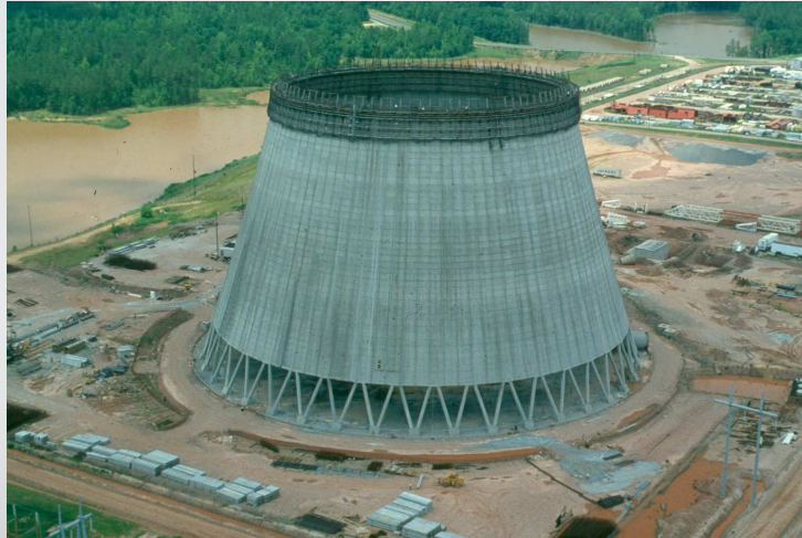
Proceso constructivo de la torre de enfriamiento de la Central Nuclear Shearon Harris (Carolina del Norte, Estados Unidos). El contorno corresponde a una curva hiperbólica.
