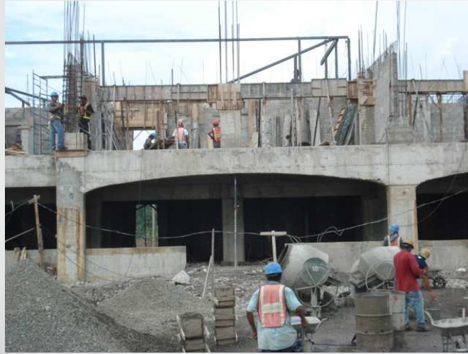
Viga de entrepiso con cara inferior curva para generar arco en fachada de hotel.
