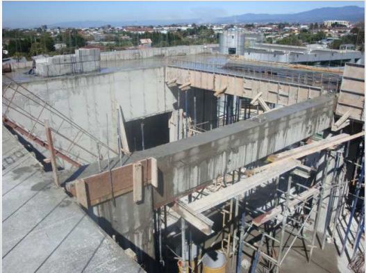
Vigas prefabricadas en sitio
