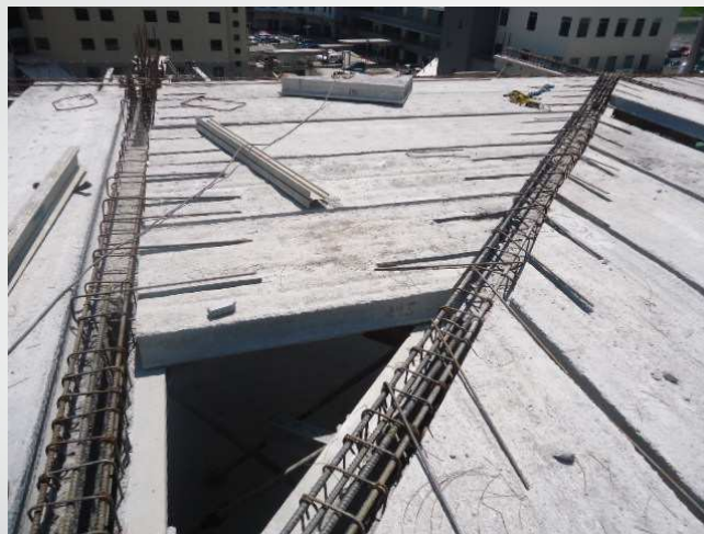
Sector de entrepiso (sistema losa extruida) en el cual una de las vigas tiene una dirección oblicua que obliga a cortes diagonales en las losas.
