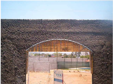
Construcción de viga cargador en forma de arco
