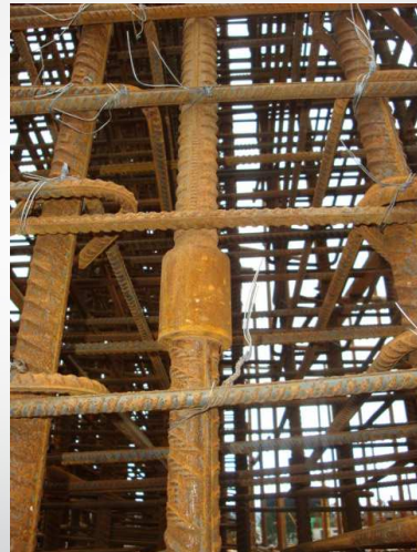
Ejemplos de empalmes mecánicos utilizados en la construcción del Estadio Nacional
