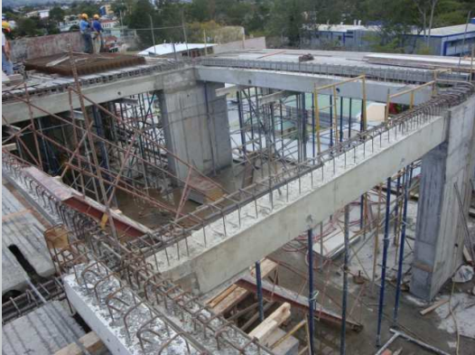
Vigas prefabricadas en sitio
