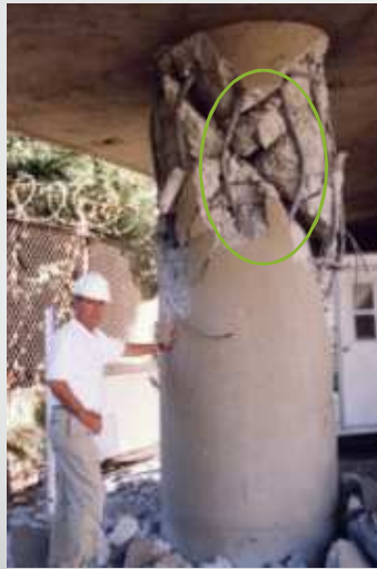
Ejemplos de pandeo del refuerzo longitudinal por inadecuado confinamiento transversal (separación excesiva de aros)
