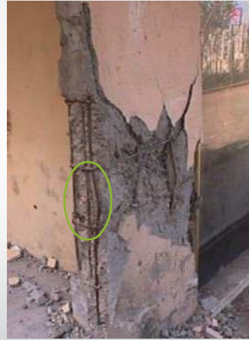
Ejemplos de pandeo del refuerzo longitudinal por inadecuado confinamiento transversal (separación excesiva de aros)
