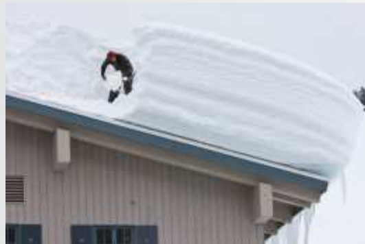
Carga de nieve en techo
