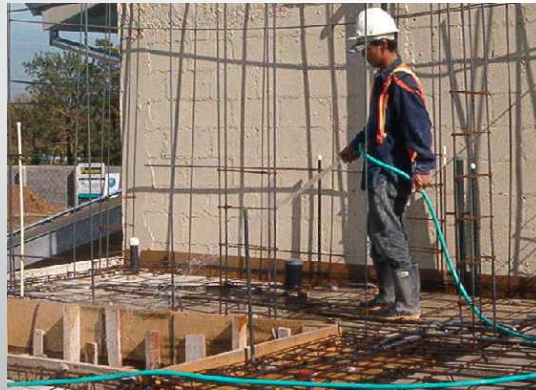
Remoción del óxido en las barras de refuerzo (varillas de acero)
