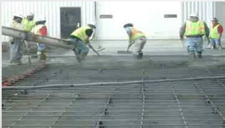
Colado de losa flotante (fundación)
