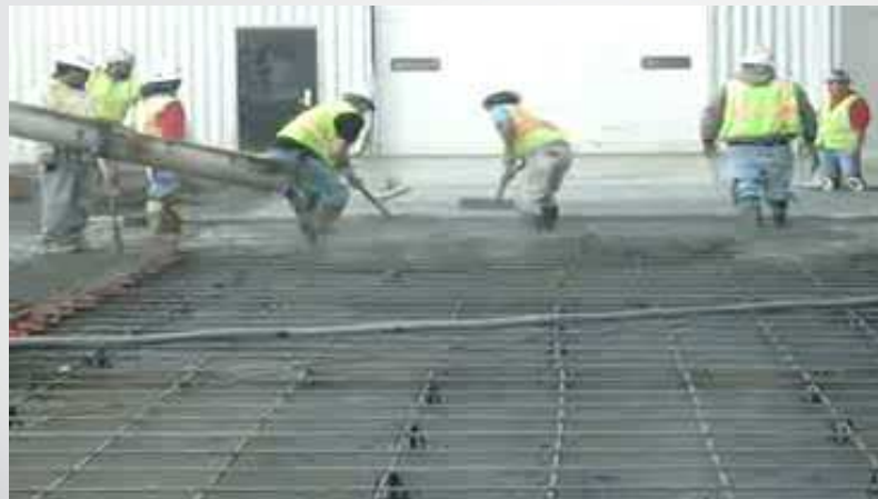
Colado de losa flotante (fundación)
