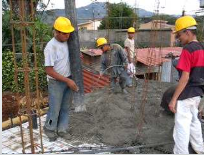
Colado de entrepiso
