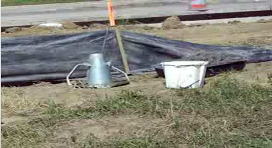
Prueba de asentamiento
